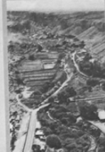
TRABAJOS DEL MOP
